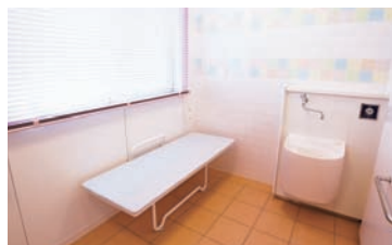
多機能トイレには、オストメイト対応設備や多目的シートも設置。
