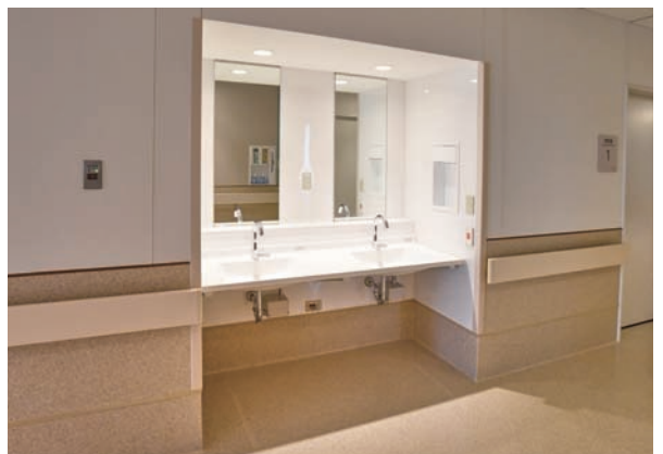
廊下に設けられた2連の洗面カウンター。車いすでもカウンターの下に足が入り使いやすい。
