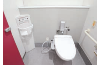
外来の女性用トイレのブース。便器は清掃のしやすい壁掛けタイプ。
