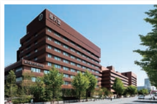
3号館の外観。レンガとルーバーが特徴的である。
