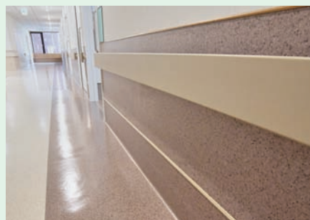
浦安病院の廊下は床を巻き上げて、掃除をしやすくしている。設計者の意図により、車いすのステップをぶつけても壁面をガードできるように、かなり高い位置まで立ち上げている。
