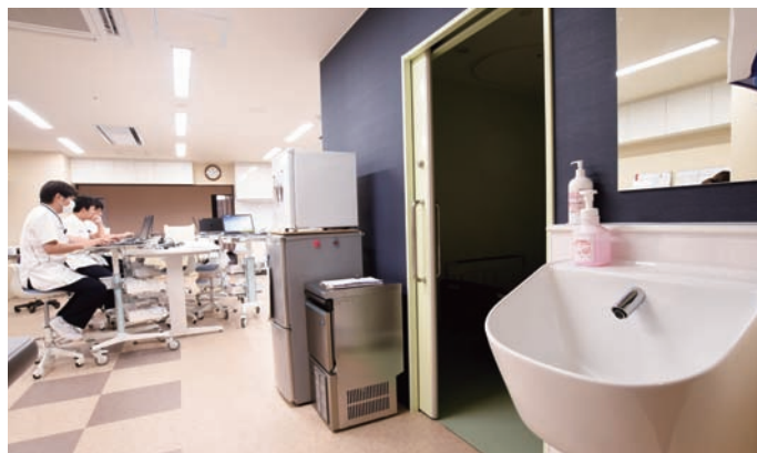
スタッフステーションの出入口に設けられた、水はねや床への飛散が少ないスタッフ用手洗器。
