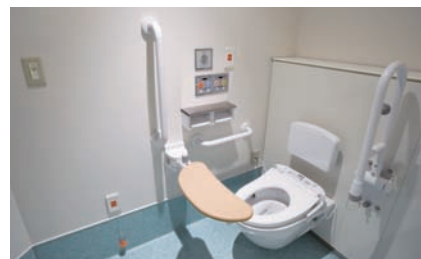
離座センサーの付いた多機能トイレ。左に見えるのがON/OFFのできるスイッチ。
