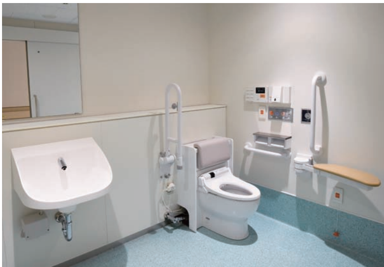
4Fの泌尿器科の病棟に設けられた、尿流量測定装置の付いた多機能トイレ。
