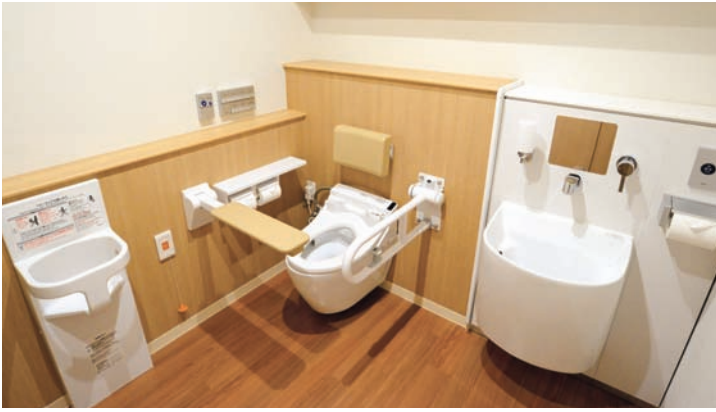
1Fの多機能トイレには、前方ボード、はね上げ手すり、背もたれなどを設置。ペビーチェアやオストメイト対応器具も備えられている。
