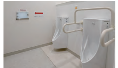
検尿用の男性用トイレ。小便器も壁掛けタイプ、床は巻き上げにするなど清掃がしやすい。
