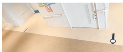
廊下の床には5mごとに目印を付けてリハビリを促進。
