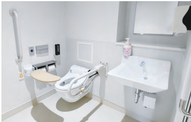
5F回復期リハビリテーション病棟の車いすトイレ。大便器は壁掛けタイプを採用し、清掃がしやすく清潔に保てるというメリットも大きい。
