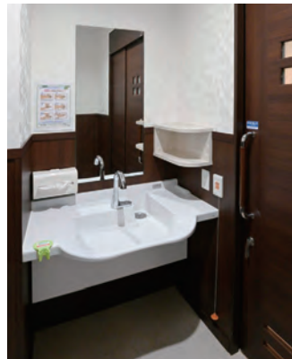
個室の手洗器。車いすで使う時期にも、回復して立って使う時期にも、どちらでも使いやすいという視点で選ばれている。
