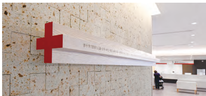
1Fの壁面は、地元の大谷石を十字ブロックに加工。赤十字を象徴するメッセージサインを取り付けた。
