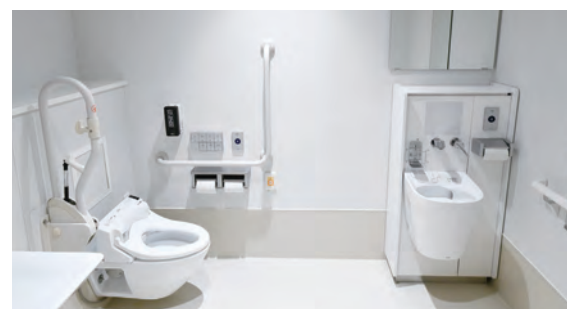
5Fの多機能トイレ。オストメイトのための設備を備えた多機能トイレは各階のコア部分に配置し、誰もが使いやすいように配慮している。
