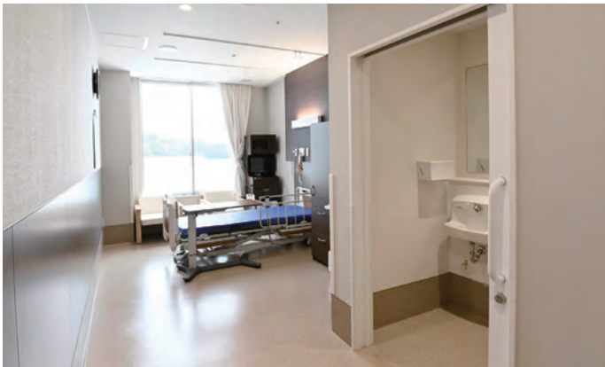
トイレが手前の廊下側にある個室。個室の壁はベッドの高さまで腰壁で保護し、ベッドの搬入時のために傷が付かないように配慮している。
