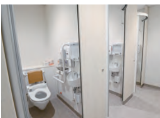
アール型扉のトイレブース内には、背もたれやL型手すり、手洗器などが設置されている。
