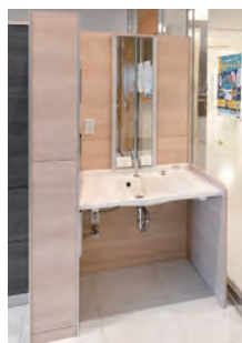
エントランス横に設けられた、車いすでも使いやすい手洗器。
