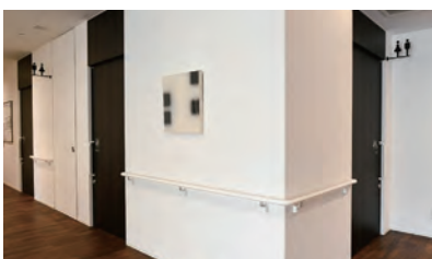
1Fエントランスの共用トイレ。サインは遠くからでも見やすいように、立体的な工夫も施されている。
