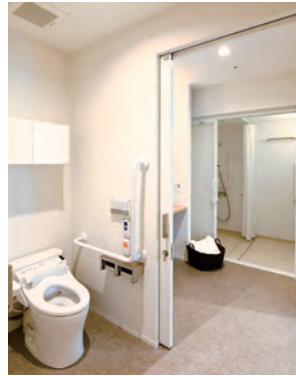
2人部屋はウォークスルーの水まわり設計。トイレにはL型手すりやはね上げ手すりを用意。
