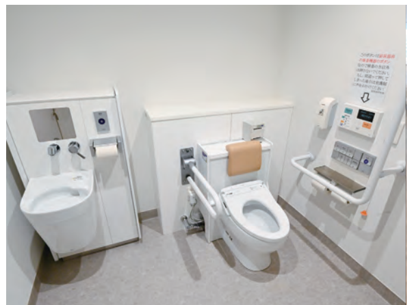
2F泌尿器科に設けられた検査用トイレ。尿流量測定装置や、オストメイトのための設備などが備えられている。
