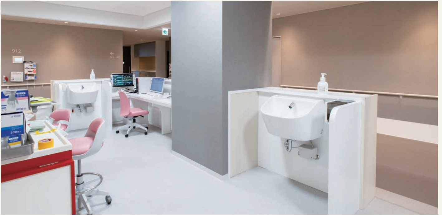
スタッフステーションの出入口の横に4ヵ所ずつ、ボウルが深くて肘まで洗える手洗いコーナーを設置。数も十分に確保されているため、短い動線でしっかりと時間をかけて手洗いを行うことができる。
