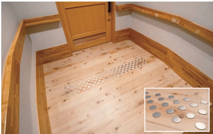
浴室の入口には、床のフラット部とスロープ部の切り替えが分かりやすいように、UDフロアを採用。ほどよい低めの突起高によって、検知をサポートしている。
