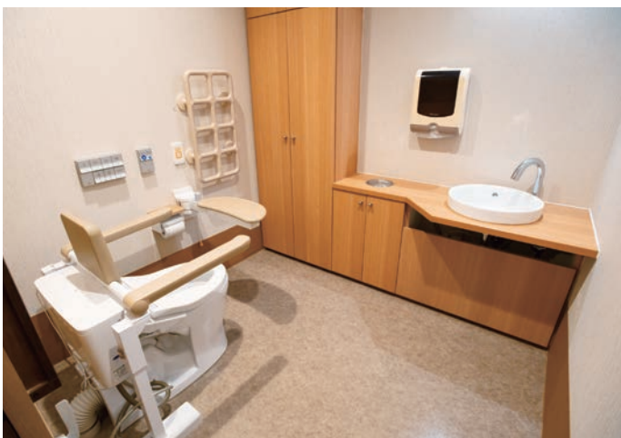
後方アプローチによって、車いすの利用者でも介助のしやすいトイレ。壁材、床材、収納、設備などが温かみのある色調で統一され、癒しの空間となっている。
