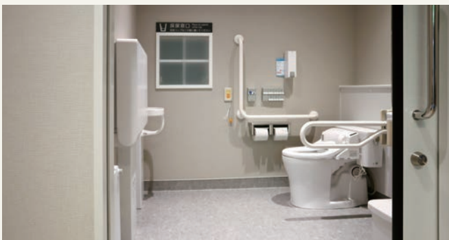
1F外来の採尿トイレ(バリアフリートイレ)。乳幼児連れにも配慮し、ベビーシート、ベビーチェア、フィッティングボードを設置している。採尿窓口は車いすでも採尿コップを提出しやすいように配慮され、便器前方の壁面に設置されている。
