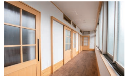
宿泊室の避難経路を確保し、法規制に対応するためにも設けた屋内テラス。用途変更による設計上の苦労も多かった。
