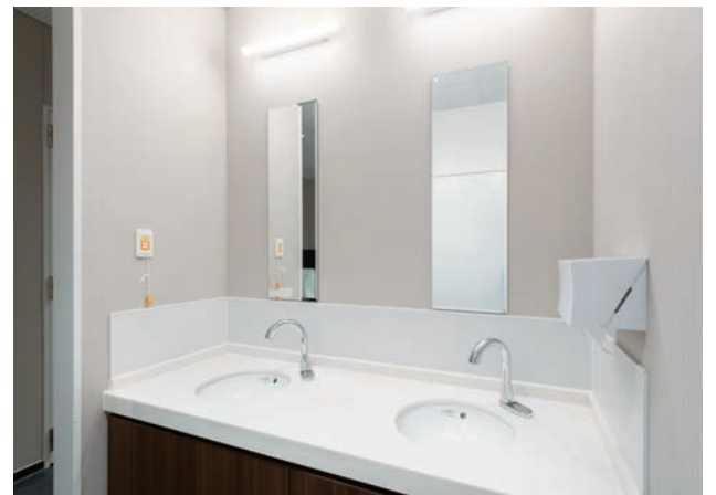
外来の男性用トイレの洗面コーナー。吐水位置が高く、広い吐水空間を確保するゲースネックタイプの自動水栓で、しっかりと手洗いができる。
