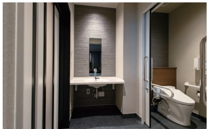
特別室の浴室・トイレ・洗面コーナー。トイレは大きな引戸で使いやすく、車いすでも大便器にアプローチしやすいようにレイアウトされている。
