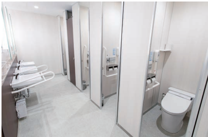
中央診療棟5Fの女性用トイレ。手洗い器の一つには手すりを付けるなど、どんな患者さんでも使いやすいように配慮されている。人感センサー式LED照明による、明るい空間である。
