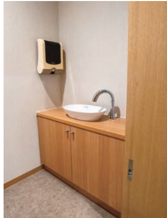
使いやすい高さを考慮した、男性用トイレの手洗い器。自動水栓が採用されている。
