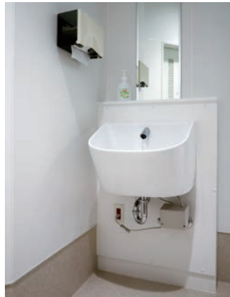
ICUのスタッフステーションの手洗いコーナーは、あふれ面の高さを850mmに設置することで腰をかがめずに利用でき、前傾姿勢による腰への負担を減らして快適に利用できる。
