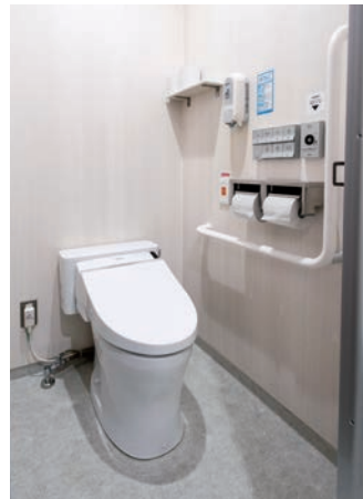
トイレのブースにはL型手すりを採用。左右勝手にも配慮されている。
