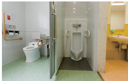
改修後の男子トイレ。左から多機能トイレ、小便器、手洗い。
