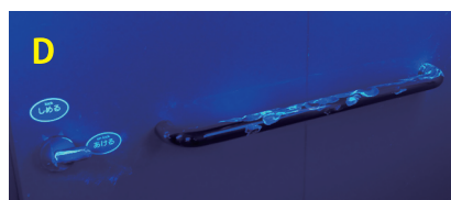
引き戸内側の手すりと鍵周辺。
