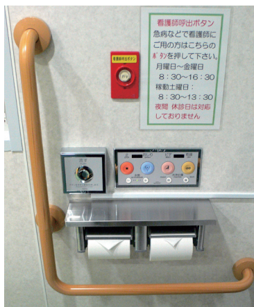
B-1 横一列に並んだカラフルな操作ボタン類。左の単独の正方形は洗浄ボタン。ナースコールは以前のままの位置です。
