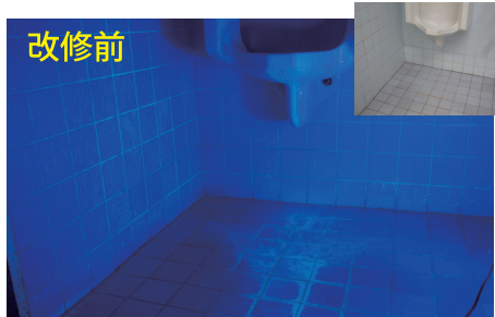
1日使用後の小便器と床の汚れ状況(廊下側)。(使用人数 106名)
