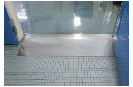
全診療科で廊下とトイレの段差（10mm程度）をスロープに変えるステンレス板が設置されています。
