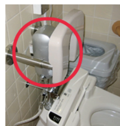
洗浄回数を計測するカウンター。
