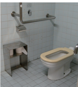
車いすトイレには脊椎損傷などの方が使いやすい便器を設置していました。
