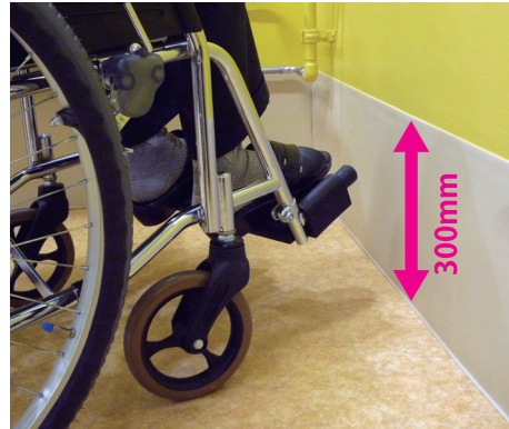
今回の改修では車いすのフットレスト・ガードとして幅木を300mm立ち上げています。
