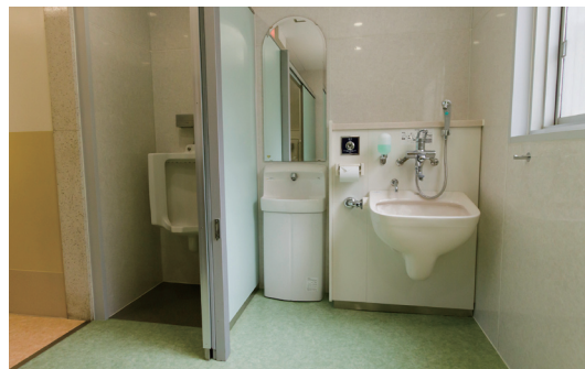
多機能トイレに設置されたオストメイト対応機器。
