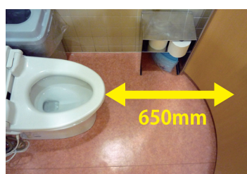
A-1 車いすなどがアプローチできるスペースを確保できました。
