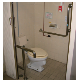
開院後、洋風便器に改装されたブース。
