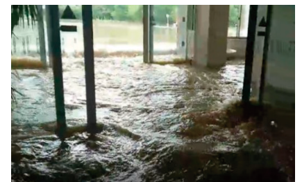
正面玄関より泥水が流れ込んでくる様子
