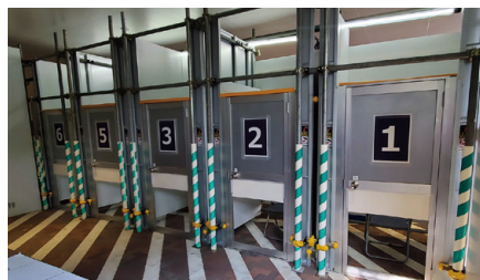
順天堂医院の1階ピロティに新設された発熱外来の待合ブース。上下を開けて風通しをよくしている。
