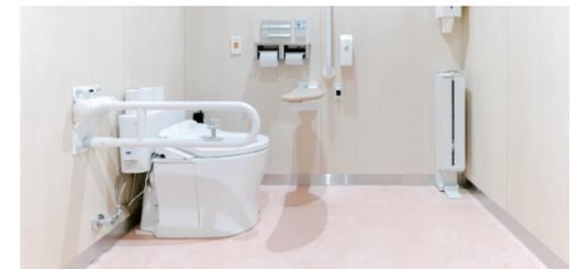
トイレ内の転倒リスクへの低減対策として、トイレ離座検知システムが導入されたブース。介助のための十分な広さがとられている。右端は尿量計測用のカップと専用ごみ箱。
