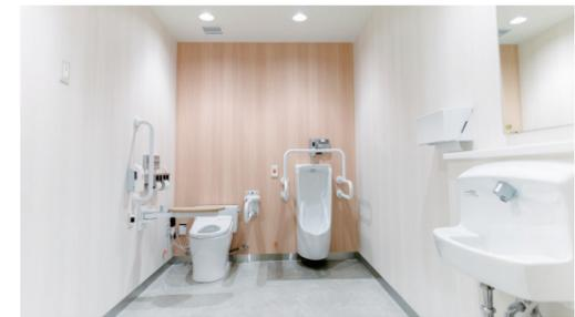
ジェンダーフリーで誰でも気兼ねなく利用できるトイレが西棟に並ぶ。洋式便器に離座センサー専用ウォシュレットと前方ボードを組み合わせ、小便器は寄り付きやすい低リップタイプ。入口横にコンパクトな手洗器が備わる。
