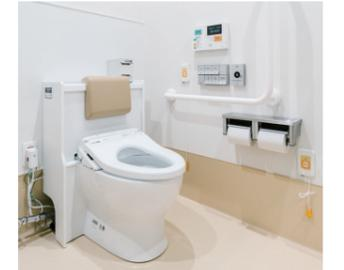
泌尿器科病棟に設置された尿量を自動計測するトイレ。通常通り排尿するだけで尿量を計測するので、衛生的で、スタッフの負担も少ない。
