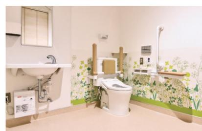
スタッフステーションに併設されていた処置室に便器を配置して車いすに対応するバリアフリートイレとして使っていた。改修では内装を改め、便器には離座センサー専用の温水洗浄便座と前方ボードをセット。介助のための十分な空間もある使いやすいトイレに生まれ変わった。
