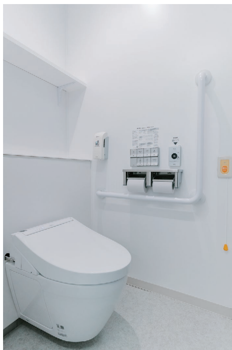
全面改修されたトイレの大便器ブース。利用者がカルテなどの入ったファイルを置ける棚や手すり、壁掛け式の便器などは共通の仕様となっている。
