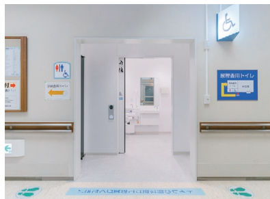
バリアフリースペースの入り口。手前に前室を設けて車いすでの出入りに配慮。入り口の前は採血の列ができるので、入り口をふさがないように、床に表示がある。
