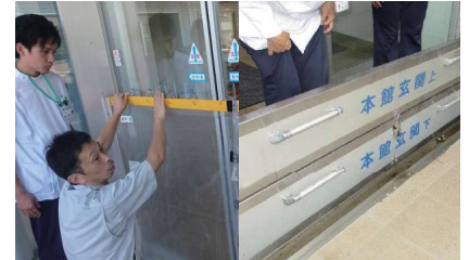
防水シート・防水パネル設置訓練の様子
