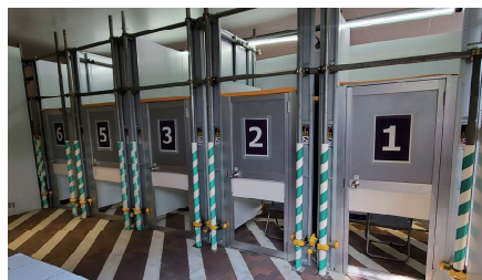
順天堂医院の1階ピロティに新設された発熱外来の待合ブース。上下を開けて風通しをよくしている。
